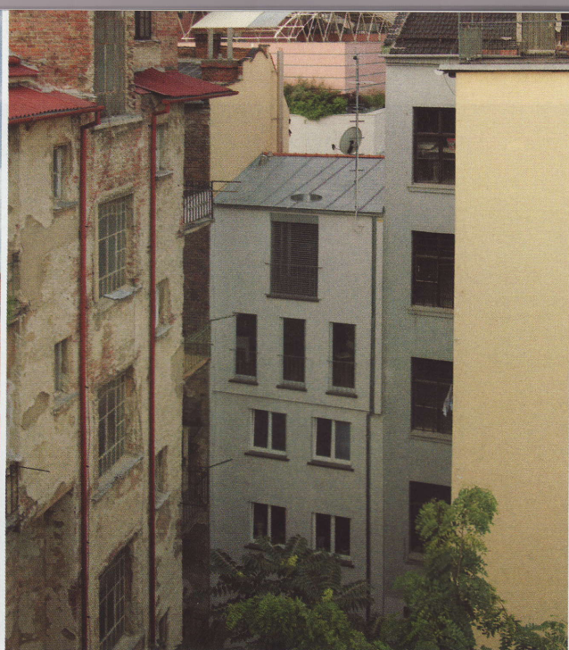
3 — Dům na Dominikánském náměstí v Brně / Dvorní fasáda
