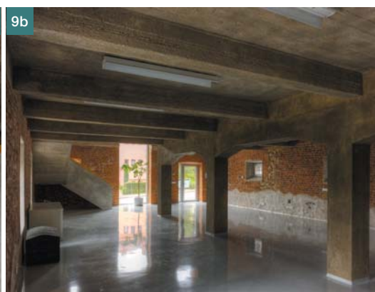
Obr. 7 Propojení s exteriérem bylo dosaženo vybouráním stávajících parapetů, v pravé části základní kámen odkazující na osobnost hraběte Albrechta Vincence Kounice, který nechal sýpku postavit ■ Obr. 7 Propojení s exteriérem bylo dosaženo vybouráním stávajících parapetů, v pravé části základní kámen odkazující na osobnost hraběte Albrechta Vincence Kounice, který nechal sýpku postavit
